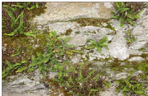
Mur maçonné de pierres de granit, de gneiss et de chaux, exposition sud-ouest : Asplenium trichomanes et Asplenium ruta-muraria , Ceterach officinarum , Mycelis muralis , Chelidonium majus
